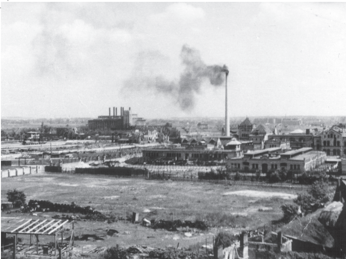
Południowo-wschodnie przedpole Cytadeli po walkach. Widoczne zabudowania Rzeźni Miejskiej (z wysokim kominem) oraz na lewo od niej dworzec Tama Garbarska. Rejon ten broniony był przez żołnierzy Grupy Bojowej „Hohlfeld”. (Z.P.)
